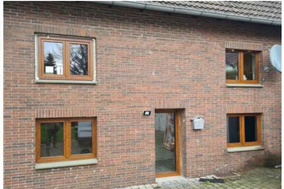
Fenster ausgetauscht: Formate/ Aufteilung ,hoch‘
