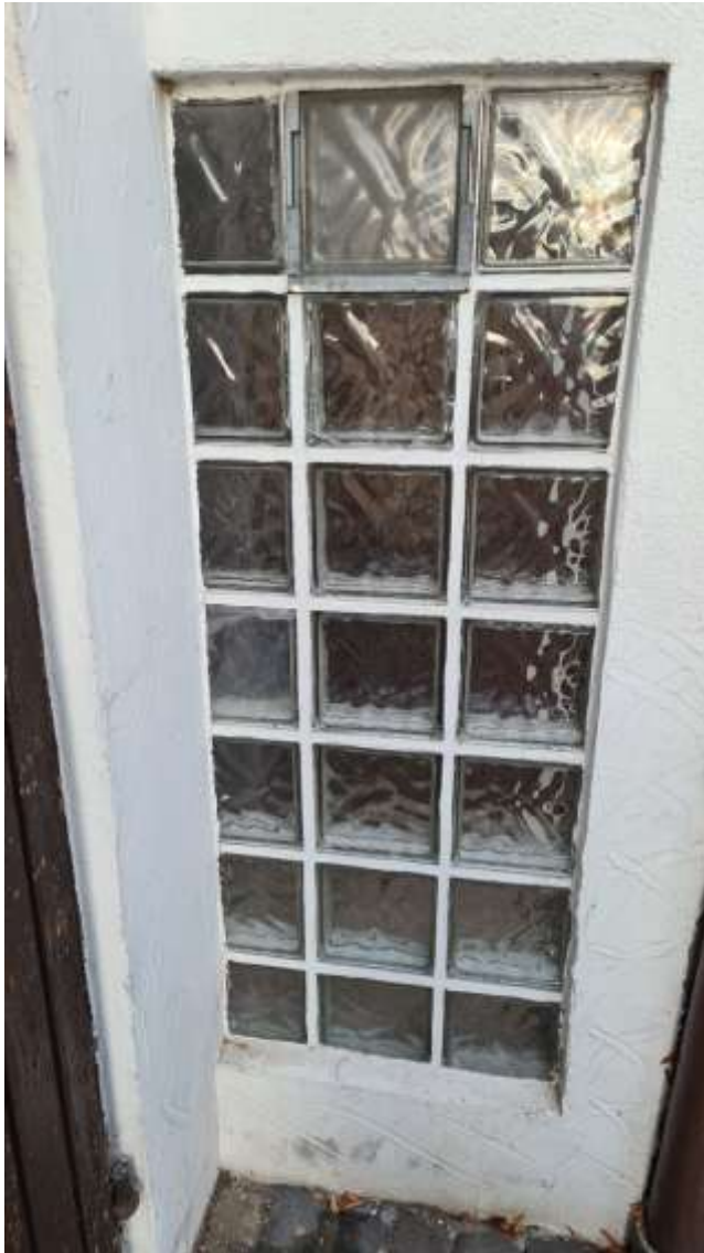
Glasbausteine ersetzt durch Fenster
